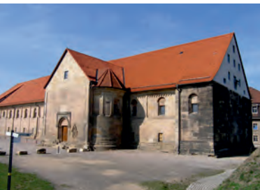
Erfurt, Peterskirche, Untersuchung historischer Verfumörtel
